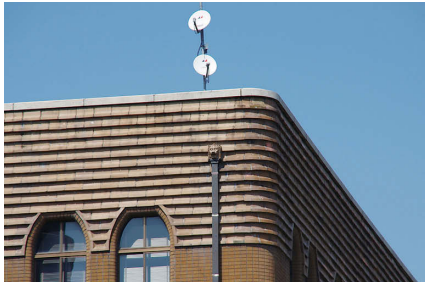
旧工学部本館の雨樋の先に、ライオンが居ます。
